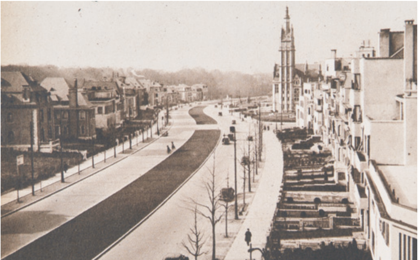
Voormalige Natiënlaan, heden Franklin Rooseveltlaan. Bâtir , 1938, 63, p. 70.
