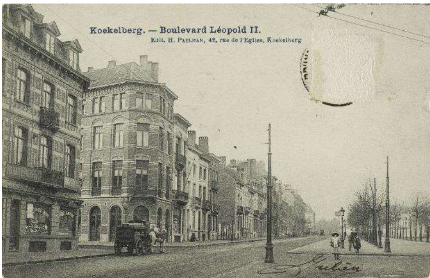
Leopold II-laan, ter hoogte van nr. 230, z.d. (Collectie Belfius Bank-Académie royale de Belgique © ARB – urban.brussels).
