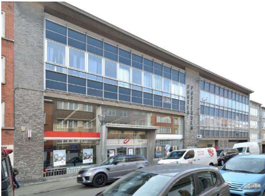
Tri postal et bureau de poste, rue de la Carrière n° 21-27 (photo 2023).
