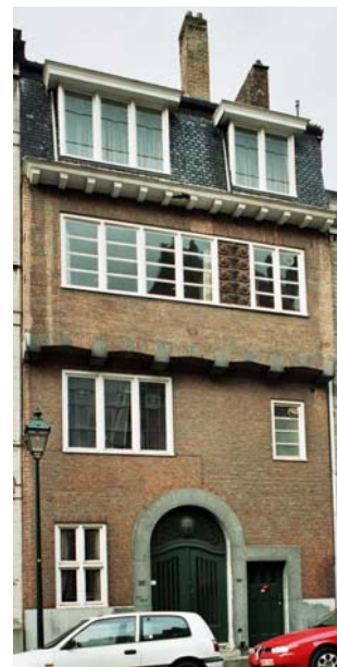
Maison, rue Wafelaert 55, 1923, architecte Jean DE LIGNE.
