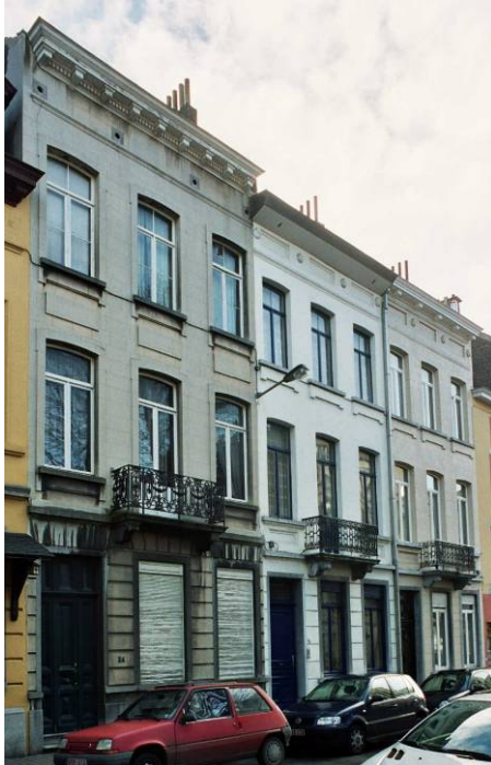
Ensemble de trois maisons néoclassiques, rue d'Ecosse 34, 36 et 38, respectivement de 1876, 1875 et 1874.
