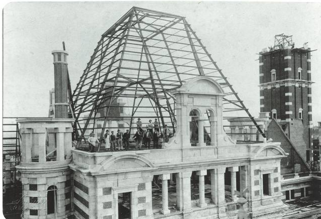
Hôtel de Ville en construction (CHDStG, I.439).
