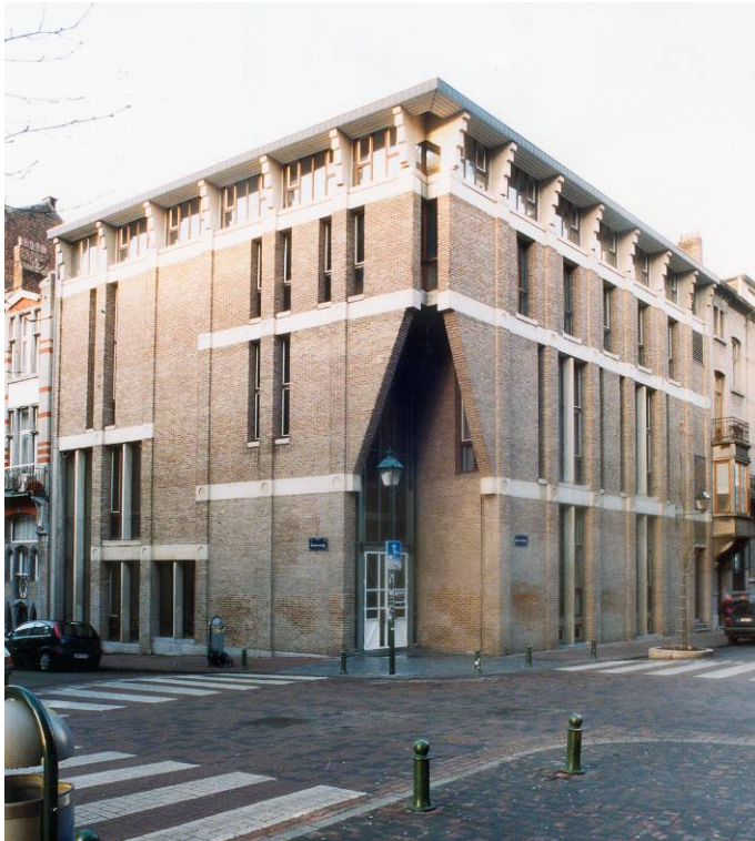
Institut supérieur Saint-Luc, 1985, angle rue d'Irlande 54-56 et rue Maurice Wilmotte 54-56-58.
