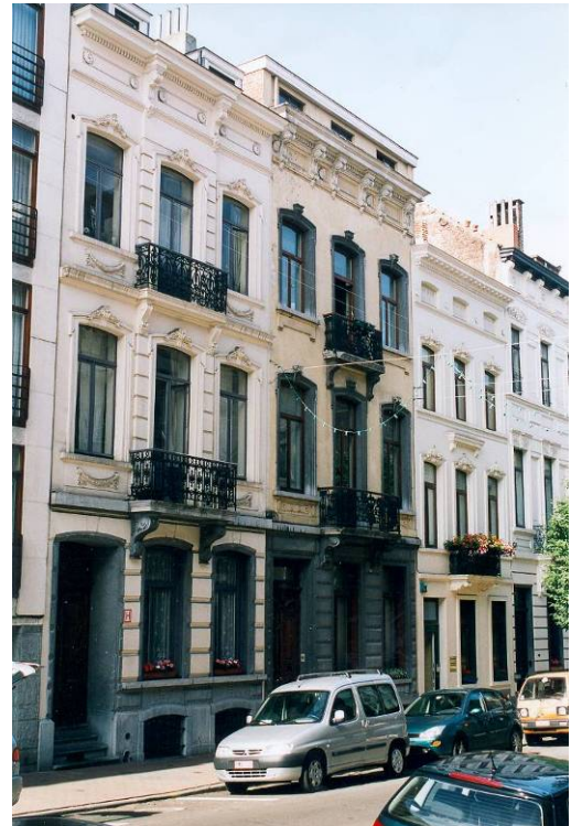
Deux maisons néoclassiques de composition symétrique, rue Berckmans, 110 et 112, respectivement de 1871 et 1870, architecte Gustave DE MAN.
