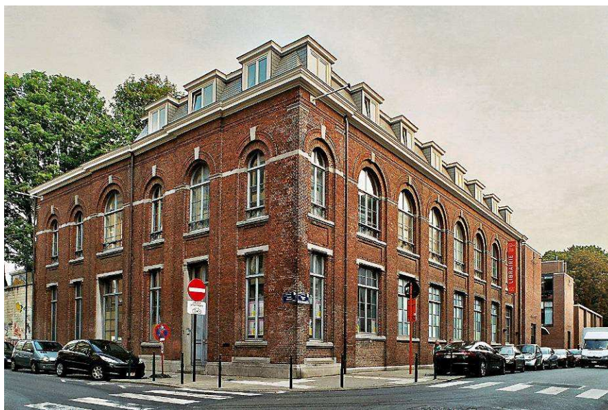
Rue de l'Ermitage 55 – 2 rue de la Vanne, façade de l'ancienne sous-station électrique, 1895 (photo 2009).
