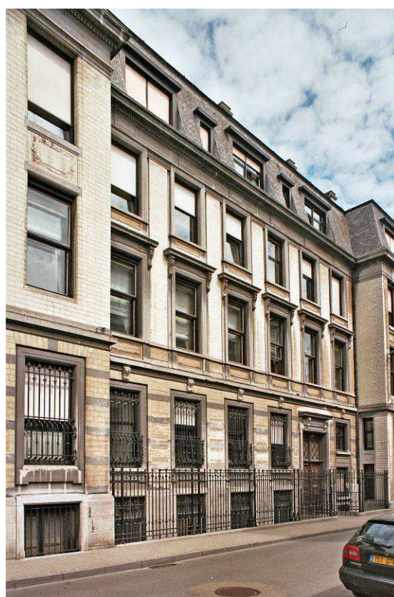
Rue du Prince Albert 31, bureaux de la firme Solvay de 1883 (photo 2009).
