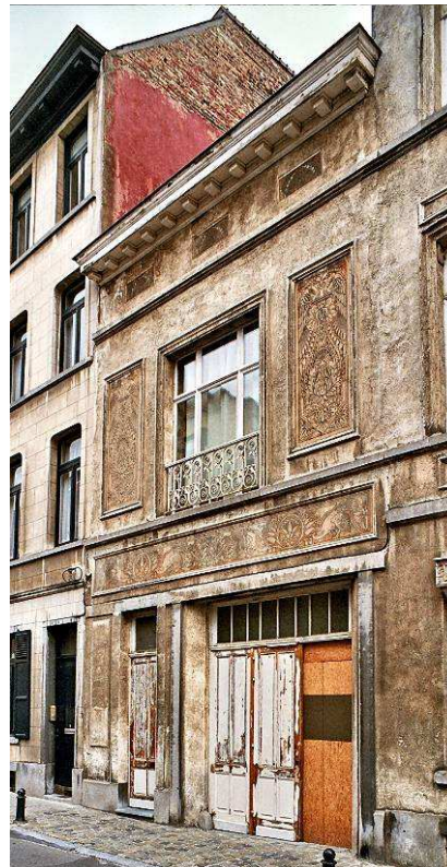
←← Chaussée de Vleurgat 77, maison bourgeoise de style néo-Renaissance flamande de 1890 (photo 2009).
