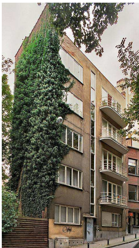
Rue de l'Ermitage 28, immeuble à appartements de style moderniste, architecte Louis-Herman DE KONINCK, 1935 (photo 2009).
