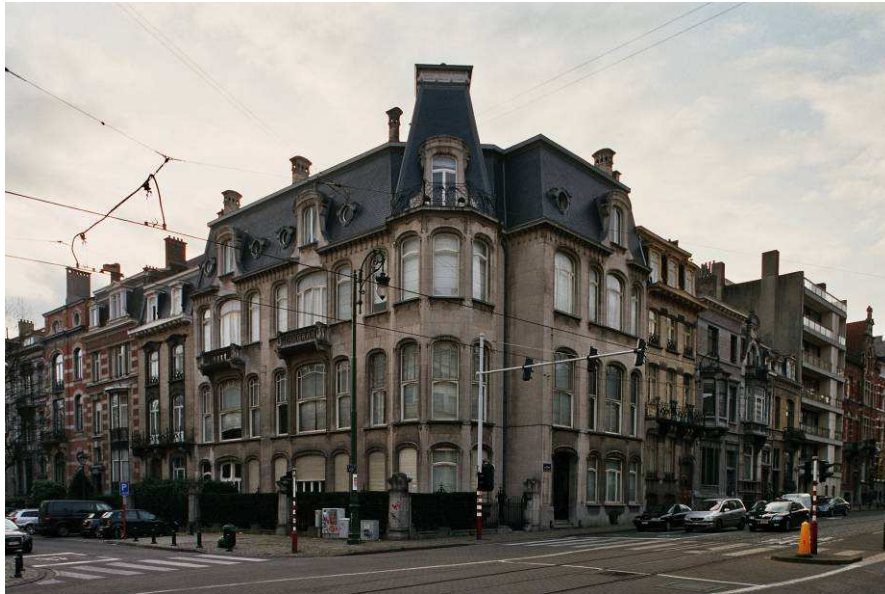
Brugmannlaan 178, 176 – Molièrelaan 177 en 179, burgerwoningen n.o.v. Paul VIZZAVONA, 1908 (foto 2006).
