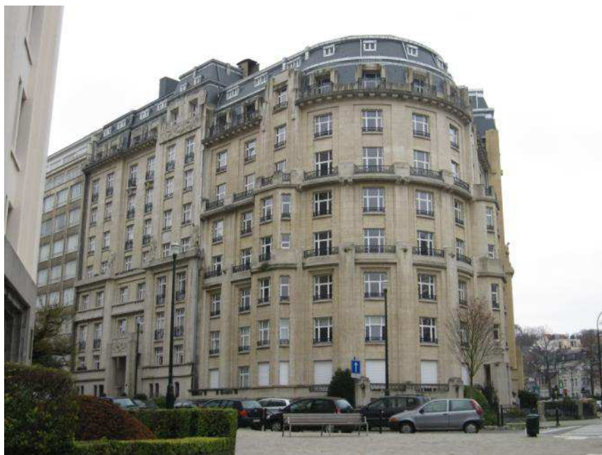
Avenue É. Duray 60-62, 64, 66, 68 – 4-4B avenue de la Folle Chanson. Le Palais de La Cambre (photo 2010).
