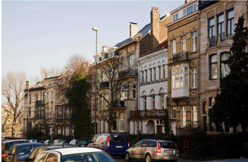
Le front bâti de la rue de la Vallée (photo 2011).
