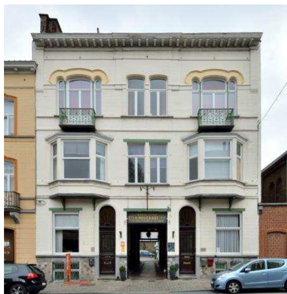
↑ Rue E. Cattoir 14-16 (photo 2014).
