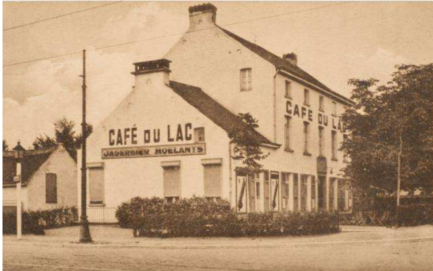
Avenue du Derby, ancien Café du Lac (démoli), s.d. (coll. Belfius Banque © ARB-SPRB).
