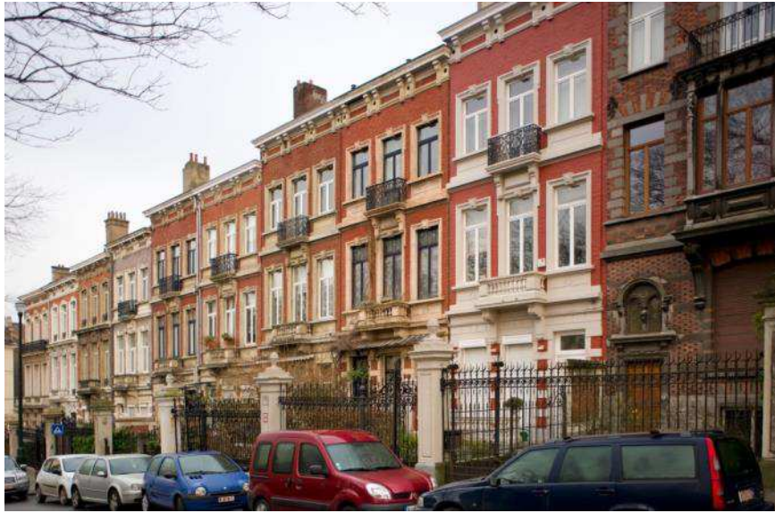
Rue Vautier 8 à 18. Maisons conçues pour É. Franchomme, 1881 (photo 2012).
