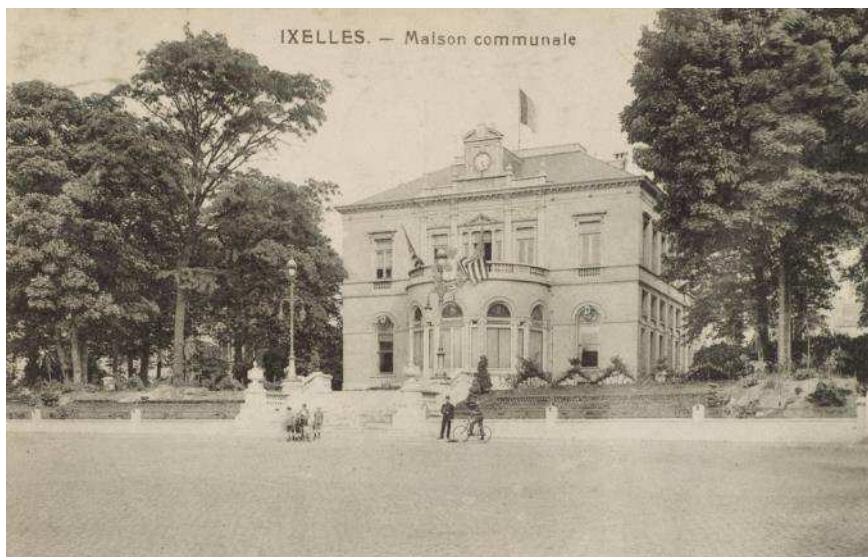
Maison communale d'Ixelles, juste après les travaux d'embellissement de 1909 (coll. Belfius Banque © ARB-SPRB).
