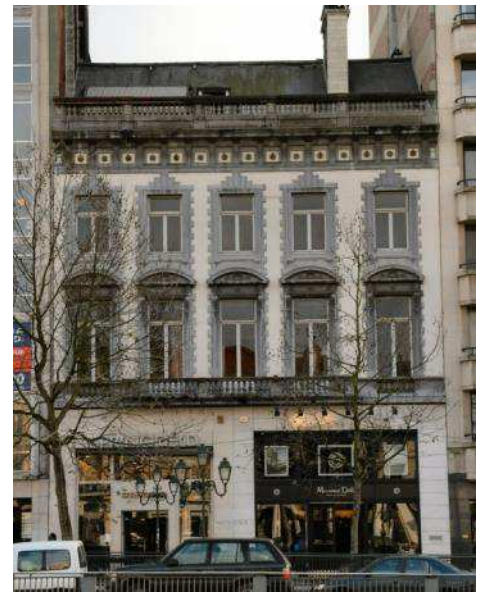
Avenue de la Toison d'Or 22-22A-22B. Architecte H. Maquet (photo 2009).
