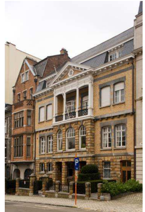
↑ Geo Bernierlaan 13. Persoonlijke woning van de architect A. Blomme, 1913 (foto 2011).
