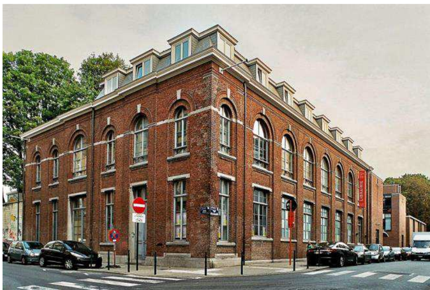
Kluisstraat 55 – 2 Verlaatstraat. Voormalig elektrisch onderstation, 1895 (foto 2009).
