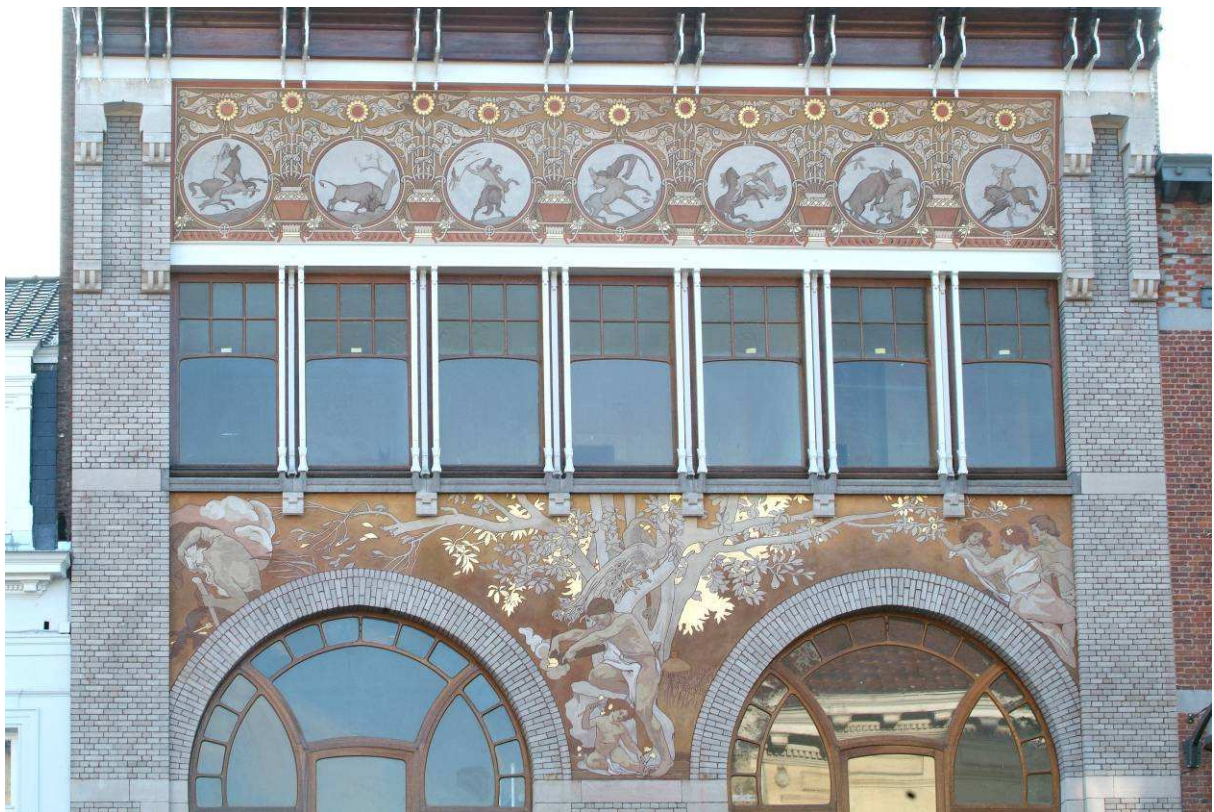
Huis Ciamberlani, Defacqzstraat 48, het sgraffito op de verdiepingen (foto 2007).
