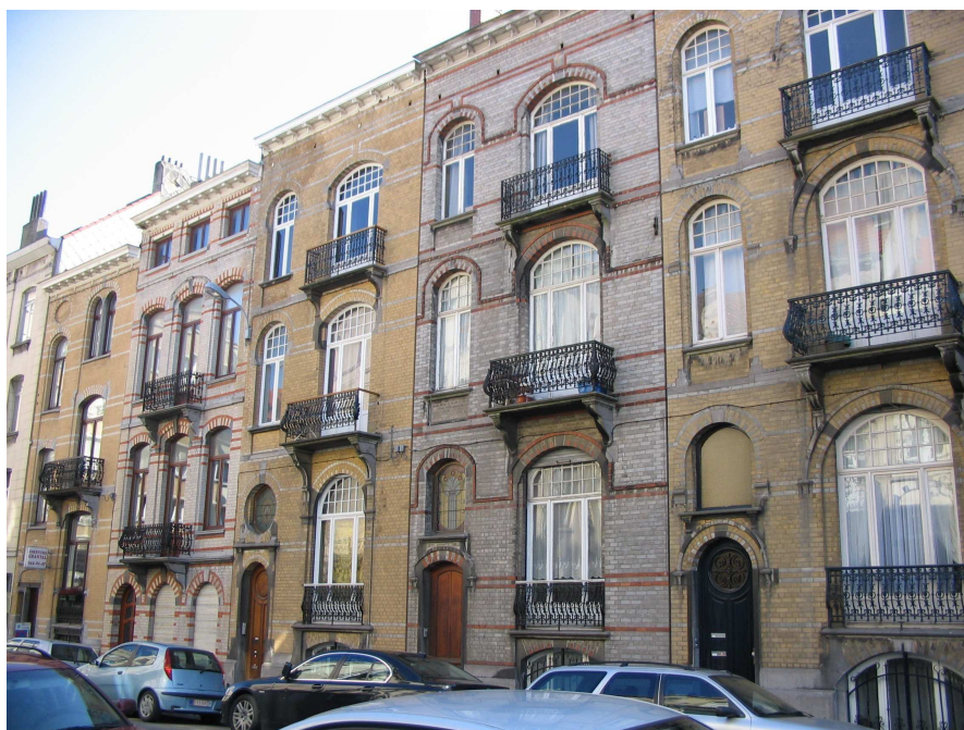
Eclectische huizenrij in de Renier Chalonstraat naar de hand van architect J. DIERICKX, 1909 (foto 2006).
