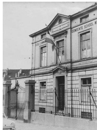
↑ Rue des Éburons 50, façade principale de l'école communale n°9, conçue en 1864 par l'architecte J. SEGERS et démolie au début des années 1960. Collection École primaire des Éburons.
