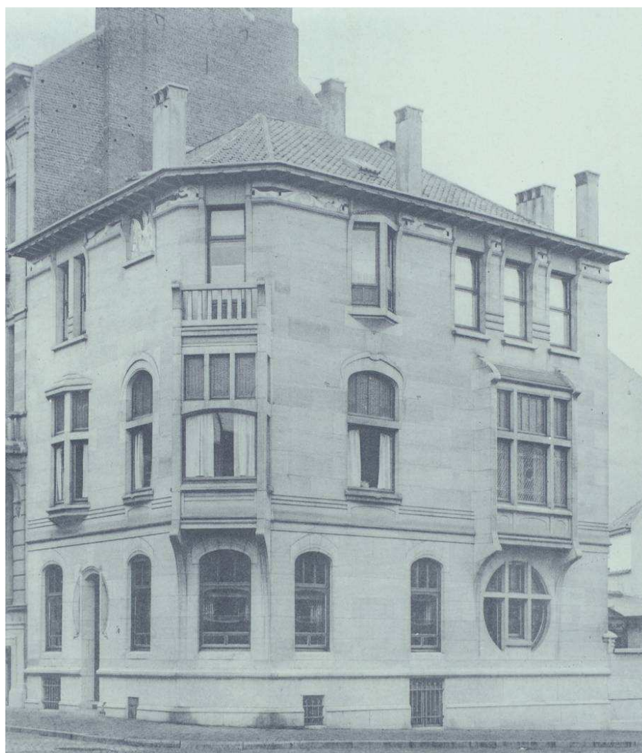
Rue Philippe le Bon 70, maison personnelle de l'architecte Victor TAELEMANS. Album de la Maison Moderne , série VIII, [1908], pl. XXXI.
