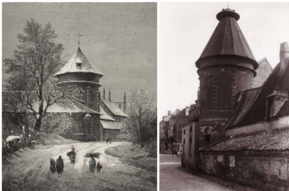
← ← Vue du château des Deux Tours, rue du Cardinal. Dessin d'Émile PUTTAERT. © Bibliothèque royale de Belgique, Bruxelles, Cabinet des Estampes.
