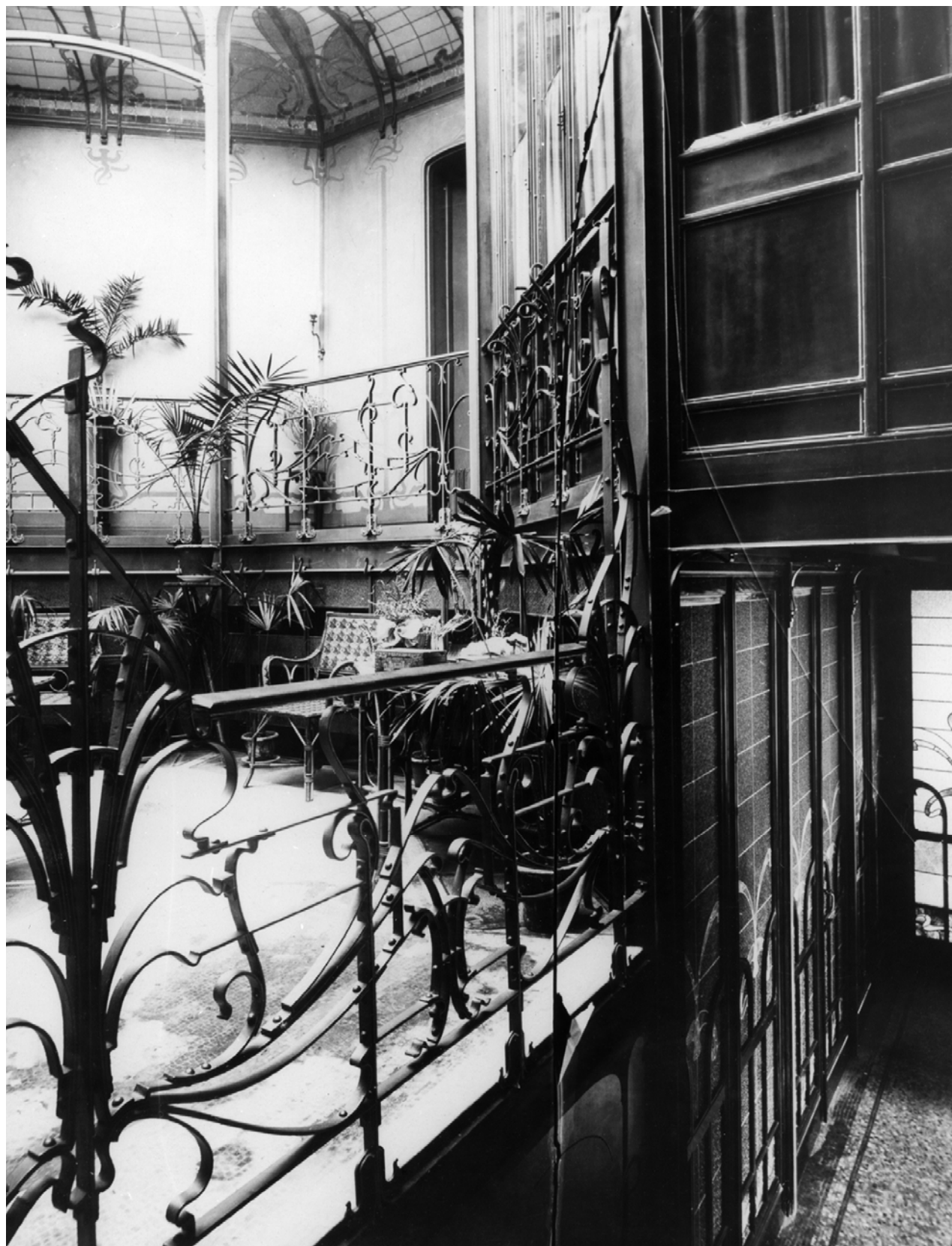
Palmerstonlaan 4, huis van Eetvelde, in 1895 ontworpen door architect Victor HORTA, gezicht op de winter tuin. © IRPA-KIK Brussel.
