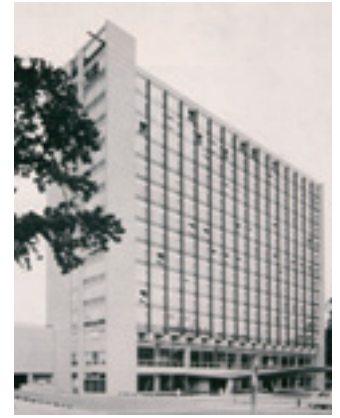
Le bâtiment S, Institut de Sociologie en 1968. Architecture 68, 84, 1968, p. 198.
