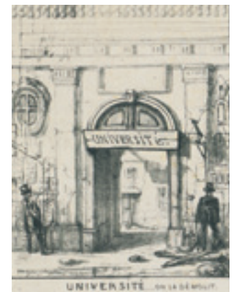
«Université... on la démolit.» Estampe satyrique relative aux grands travaux de Bruxelles, f°, lith., vers 1855. © KBR, cabinet des estampes, SV23257.
