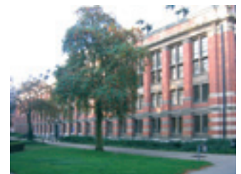
Bâtiment A, façade arrière, 2006.
