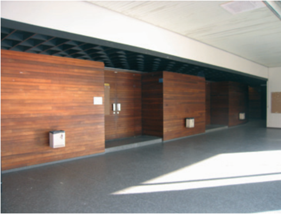
Bâtiment D, hall devant les auditoires du rez-de-chaussée en 2006.
