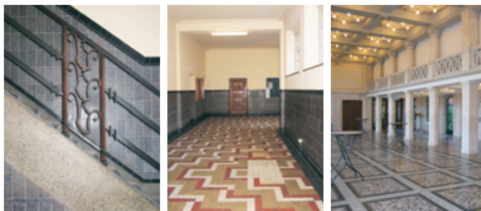
Bâtiment A, détail d'une rampe en fer forgé en 2006.
