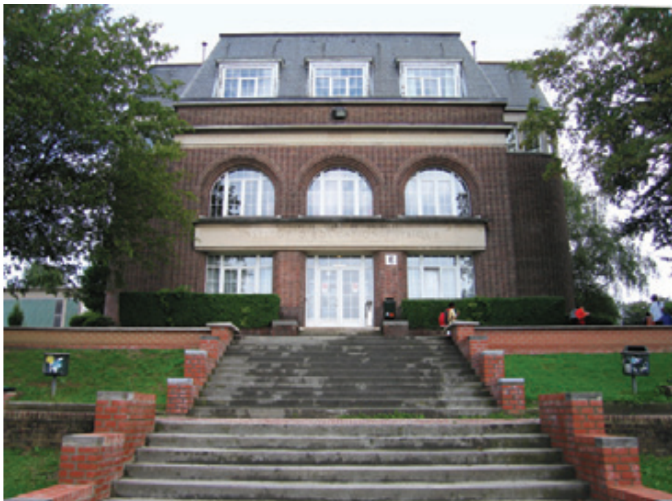
Bâtiment E2, façade principale en 2006.
