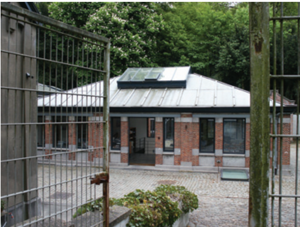
Ancien hangar en appentis en 2006.
