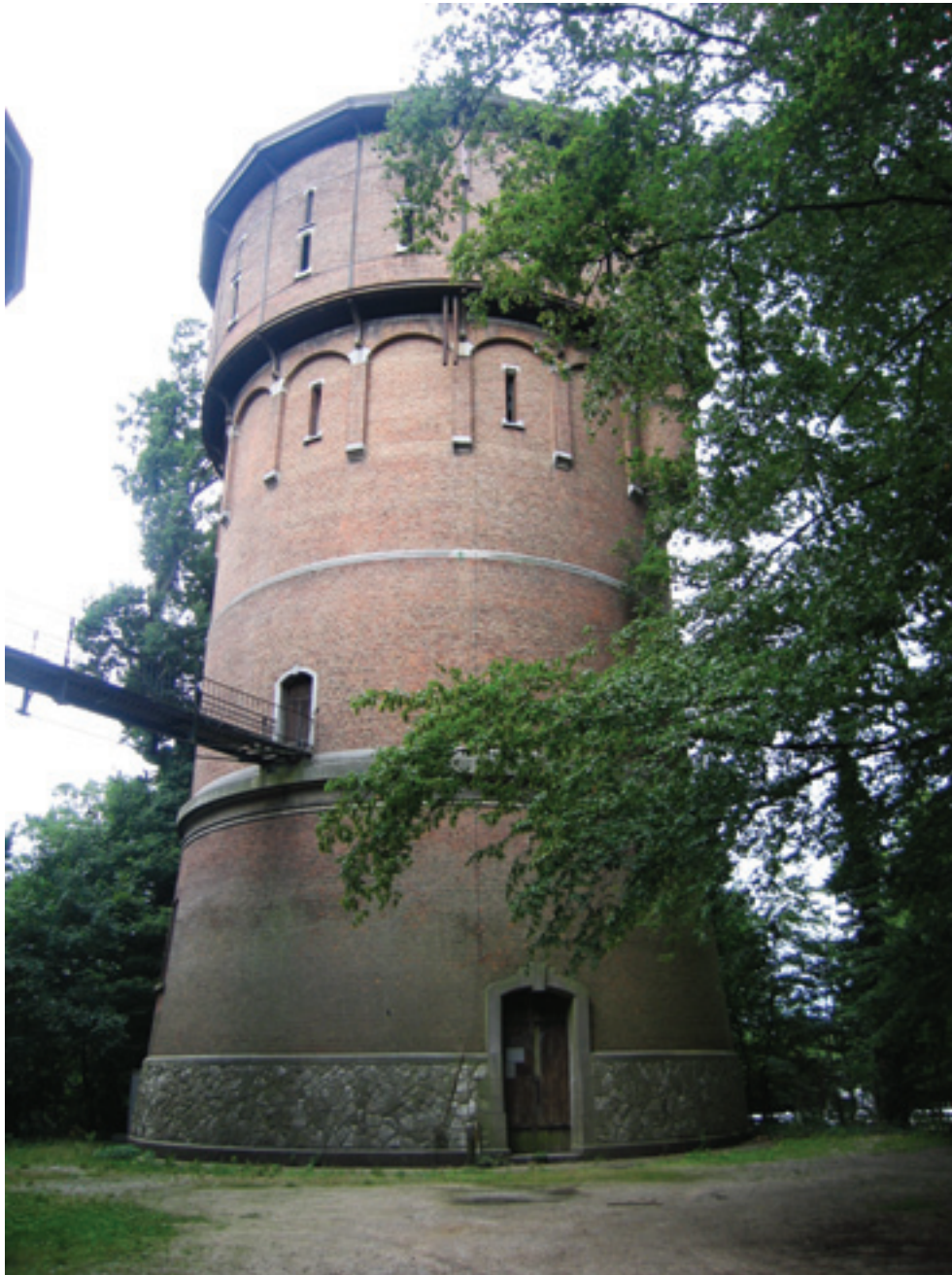
Château d'eau conçu en 1890, 2007.
