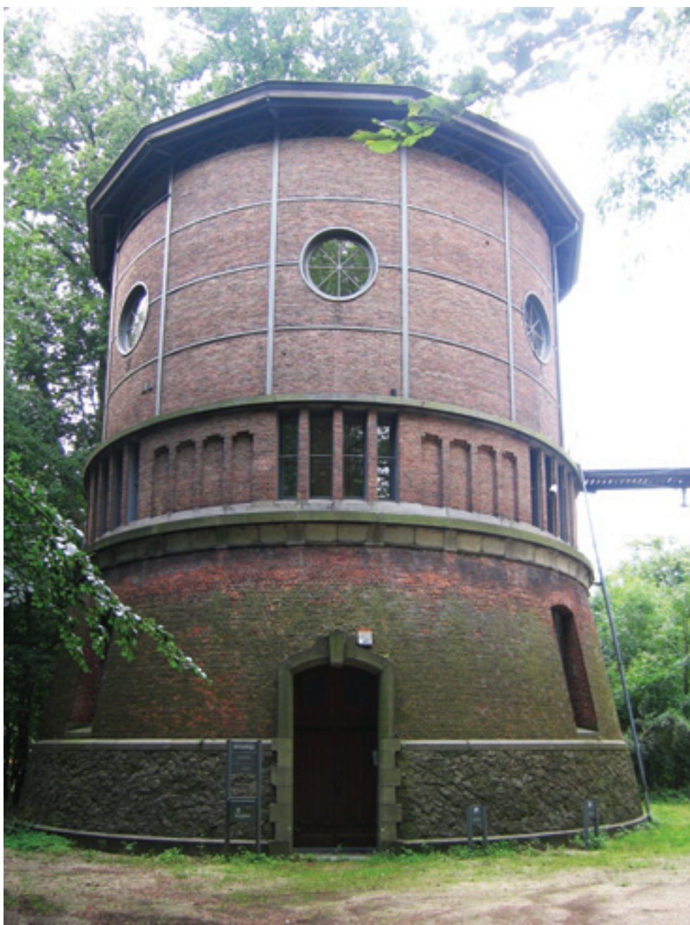
Château d'eau conçu en 1879-1880, 2007.
