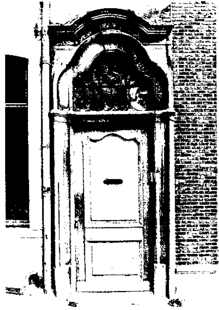
740. Ons-Heerstraat nr. 15. Deuromlijsting.
