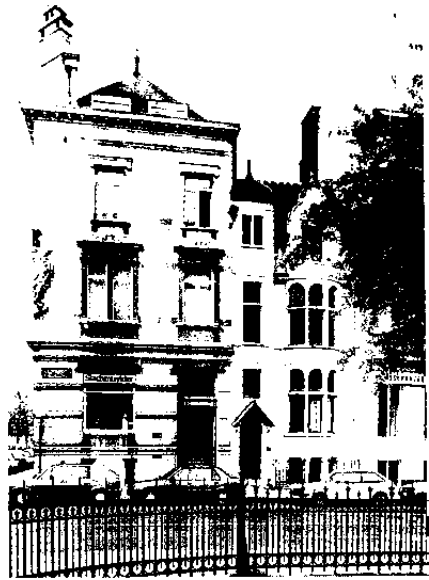
453. Jan Jacobsplein nr. 15, voormalige «woning Solvay» (1894) en 17, voormalige «woning Vanderborght» (1894).
