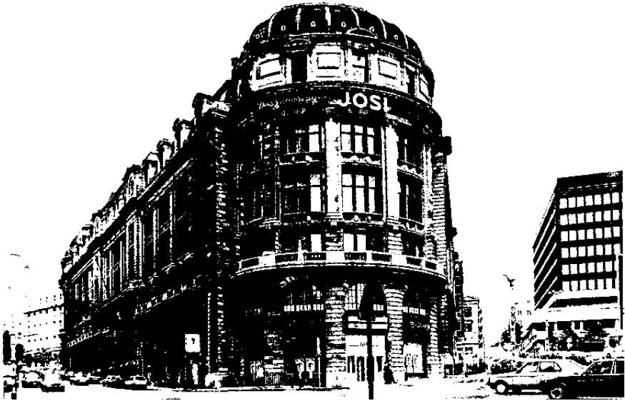
520. Koloniënstraat nr. 1-21. Voormalig bankgebouw «Caisse Générale de Reports en de Dépôts» (1911).
