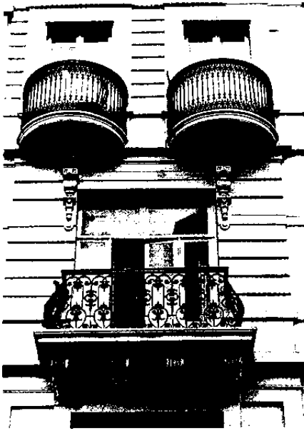
735. Onderrichtsstraat nr. 18, 20 (1876). Balkons.
