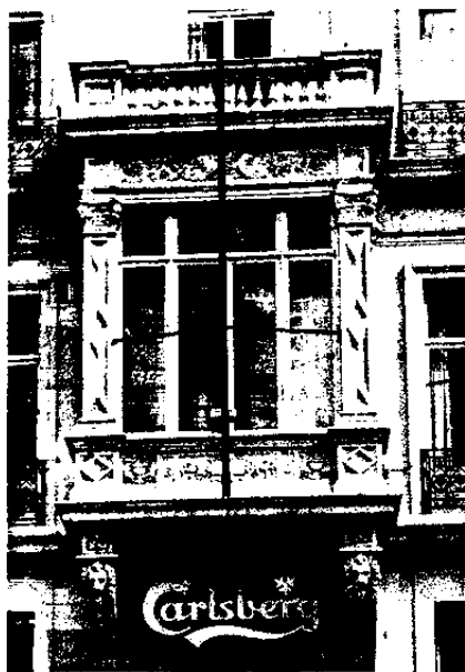
444. IJzerenkruisstraat nr. 1-3 (1877). Erker.
