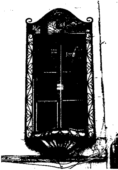
498. Kleerkopersstraat nr. 7. Vensteromlijsting (1925).
