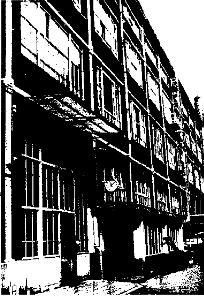
227. Eikstraat nr. 8. Ateliers en magazijnen van de «Gasdienst» (1901).
