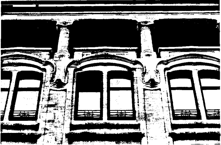
75. Arenbergstraat nr. 11-13. Voormalige juwelierszaak gebr. Wolfers (1909). Loggia.
