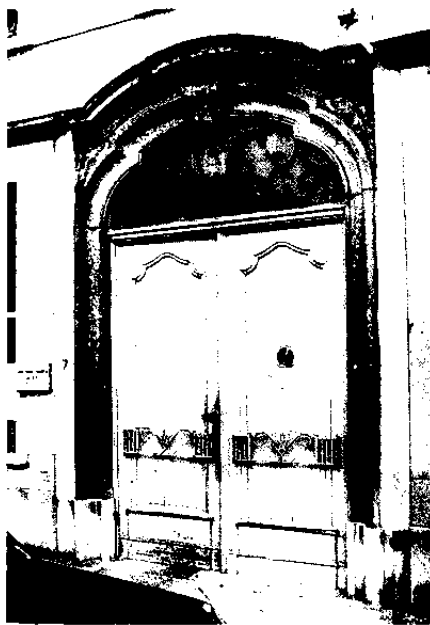
166. Brandhoutkaai nr. 5-7. Poortomlijsting.
