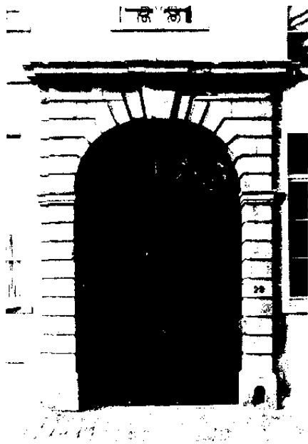
317. Grootgodshuisstraat nr. 29 (1827). Poortomlijsting.
