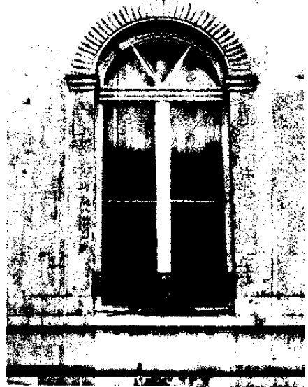
4. Accolaystraat nr. 15 (1821). Bel-etagevenster.
