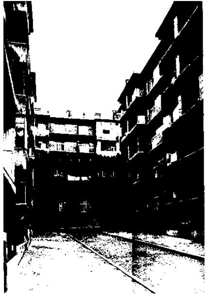
135. Blaesstraat nr. 67-77. Z.g. «Cité du Miroir» (1937-1939). Binnenhof.
