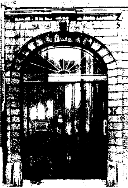
96. Baksteenkaai nr. 26. Poortomlijsting.
