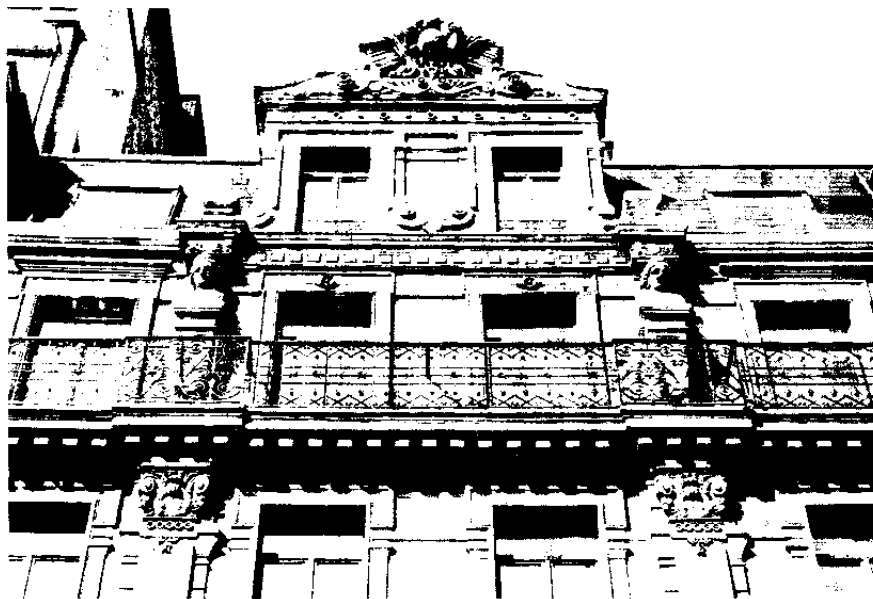
299. Grétrystraat nr. 22-24 (1874). Dakvenster.
