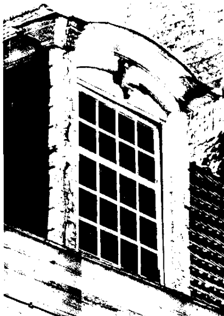
71. Arduinkaai nr. 34. Voormalig herenhuis van der Stegen de Putte, later de Spoelbergh. Centrale dakkapel.
