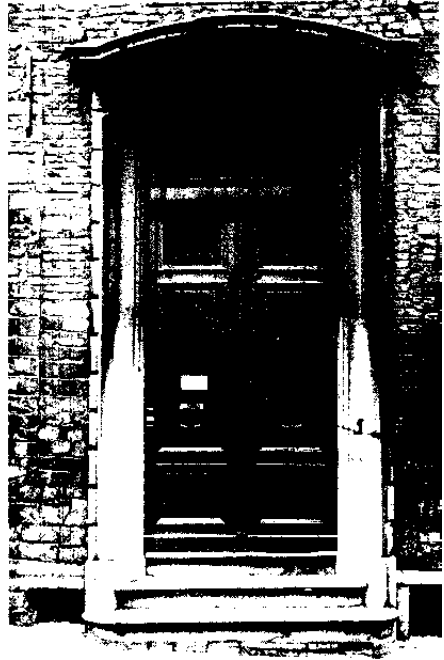
225. Eikstraat nr. 5. Voorgevel. Deuromlijsting.
