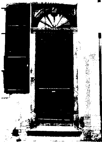
122. Begijnhofstraat nr. 15-17. Deur.
