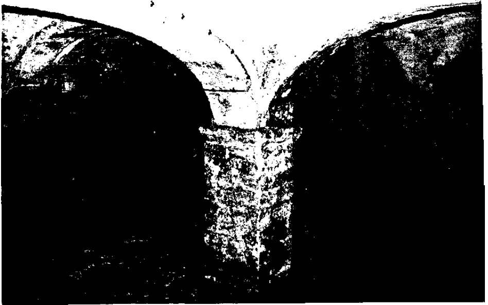
228. R. du Chêne, 27. Maison Schott. Pilier de la cave.
