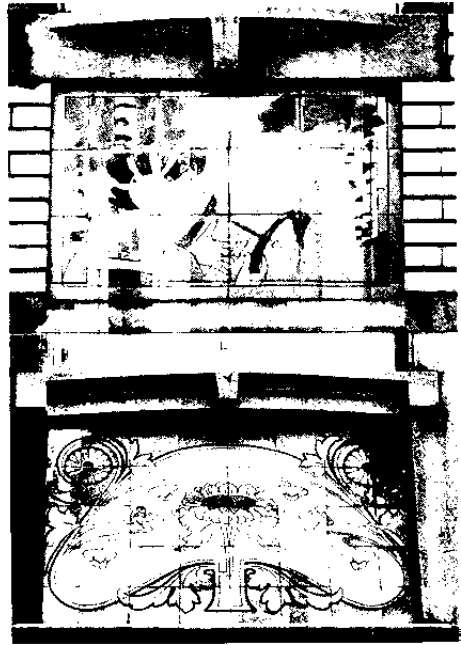
235. R. de la Clé, 4 et 24-26. Appuis «à bec» et panneaux céramiques aux allèges.
