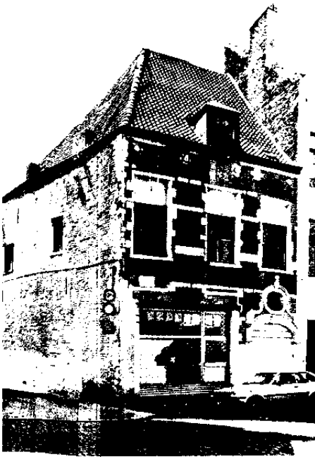
171. Quai aux Briques, 62.
