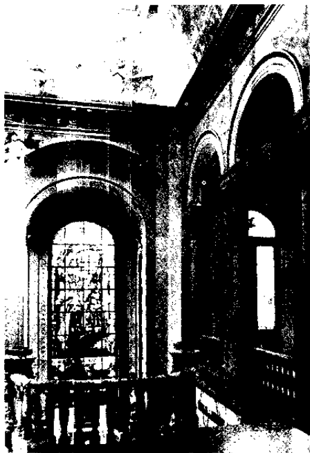
270. R. du Congrès, 33-33A. Cage d'escalier.
