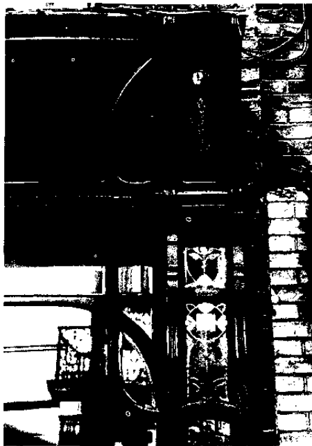
280. R. de la Croix de Fer, 49-51. Détail de la vitrine du n° 51.
