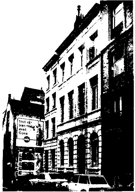
138. R. de Bon Secours, 5, 7 et 9-11.
