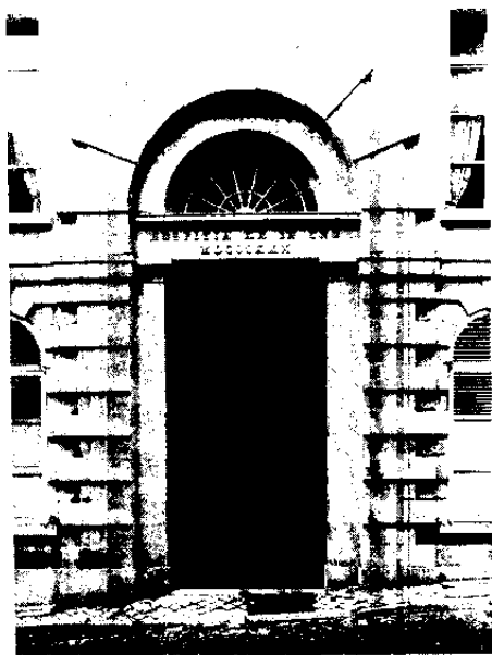
10. R. d'Accolay, 36. Hospices Réunis. Porte de la façade de l'aile S.
