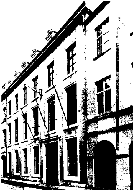
161. R. Brederode, 21-21A. Siège de la Fondation Roi Baudouin.
