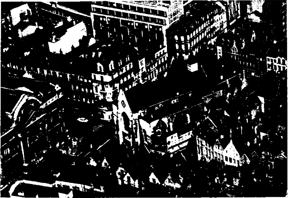
98. R. au Beurre. Toitures des maisons et de l'égl. paroiss. St-Nicolas.
