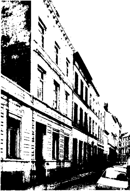
95. R. du Béguinage, 24, 26 et 28.
