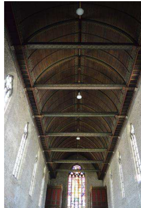
Het plafond en de balken van het schip (KMKG, 2014).
