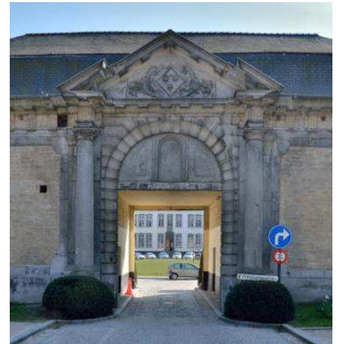
Toegangspoort van de abdij (foto 2016).
