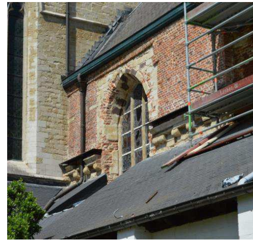
Overblijfselen van een kroonlijst van het romaanse type op de zuidmuur van de Onze-Lieve-Vrouwkapel en de kapittelvleugel (KMKG, 2014).
