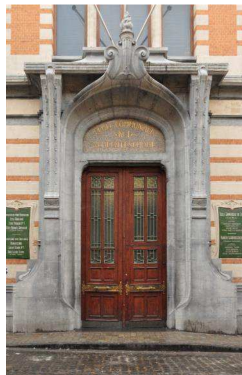
↖ Rue Josaphat 229, École n° 1, sgraffites aux étages (photo 2013).
