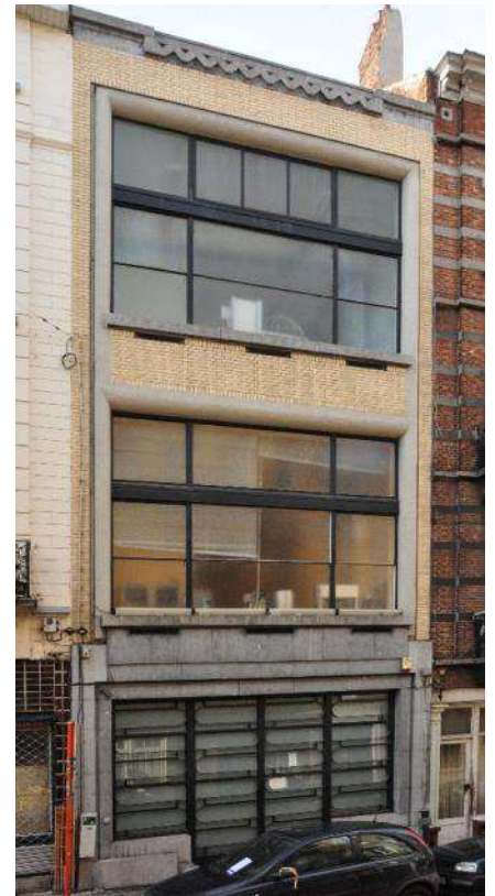
Rue Josaphat 215, extension de l'École n° 1 (photo 2013).
