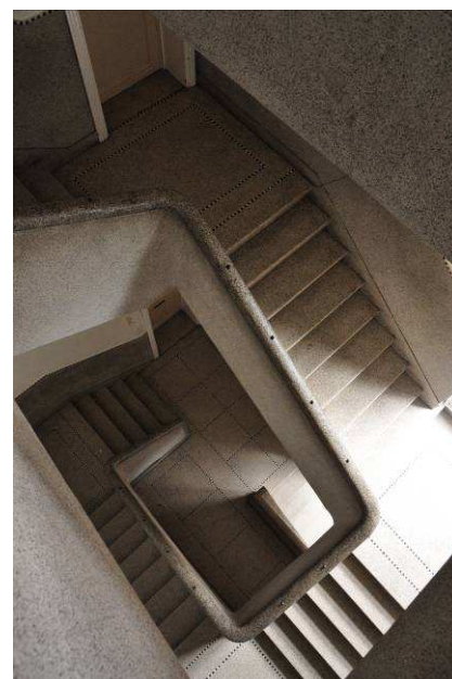
↓ Corps de classes, cage d'escalier (photo 2011).
